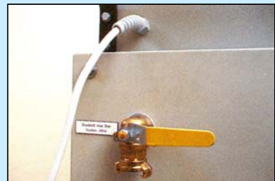
Druckluftabreinigung von Hand über einen Kugelhahn
